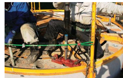
【Install Reinforcing Bar】
