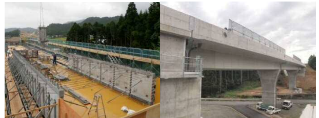
本所川橋 (西日本高速道路(株)、2011年)
