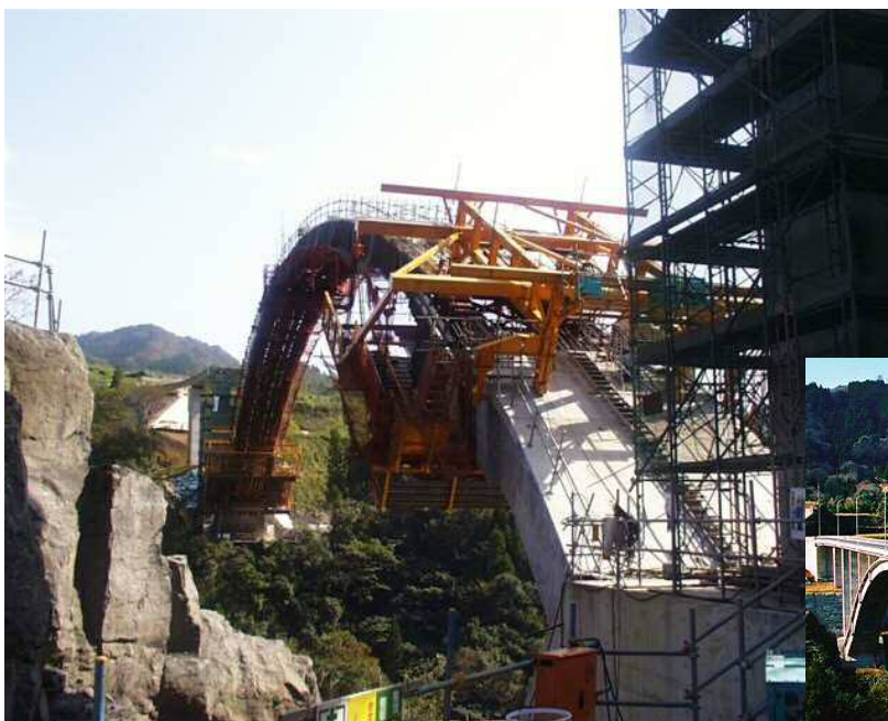
鋼管アーチのコンクリート巻立て状況
