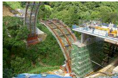
鋼管アーチの架設(ロアリング工法)
