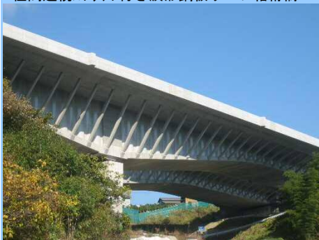
日見夢大橋 (NEXCO西日本, 2019年) 連続ラーメン波形鋼板ウェブエクストラード橋
