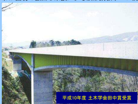
小野橋 (NEXCO東日本, 2010年) 3径間連続ラーメン波形鋼板ウェブ箱桁橋
