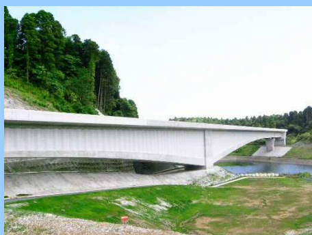
塩川線 (NEXCO西日本, 2017年) 2径間,3径間連続ラーメン波形鋼板ウェブ箱桁橋
