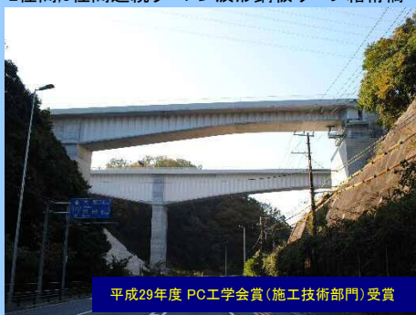
塩川線 (NEXCO西日本, 2017年) 2径間,3径間連続ラーメン波形鋼板ウェブ箱桁橋
