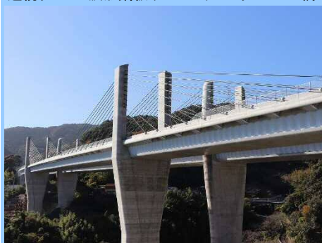
日見夢大橋 (NEXCO西日本, 2019年) 連続ラーメン波形鋼板ウェブエクストラード橋
