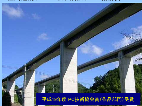
新戸川橋 (NEXCO中日本, 2013年) 8径間連続リブ付き波形鋼板ウェブ箱桁橋
