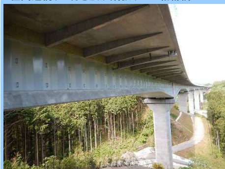
新戸川橋 (NEXCO中日本, 2013年) 8径間連続リブ付き波形鋼板ウェブ箱桁橋
