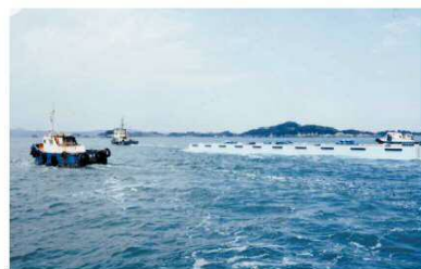
下床版鋼材挿入
