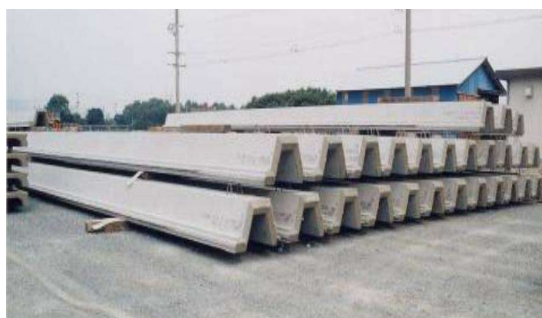
【部材仮置き状況】
