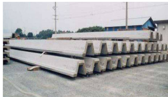
【部材仮置き状況】
