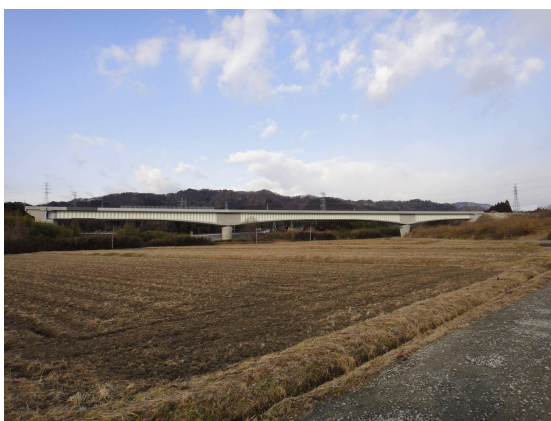
写真-1 工事完了後全景
