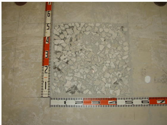
写真-4 ベースグラウト粉砕箇所
