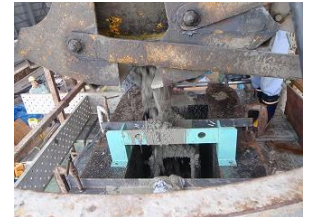
写真-3 打設状況
