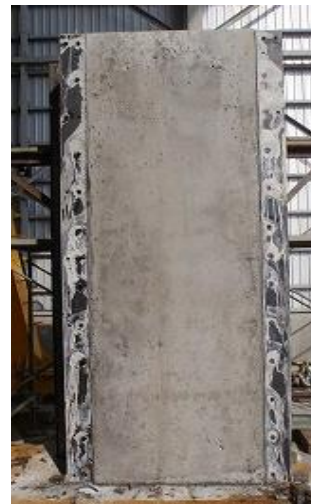
写真-4 打上り状況
