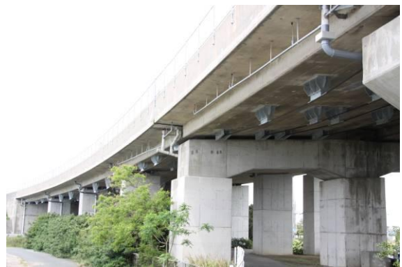
写真-2 補強完了全景
