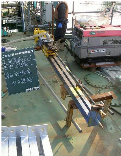
写真-2 削孔機械
