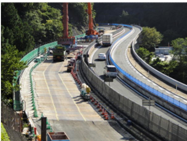
写真-1 施工状況
