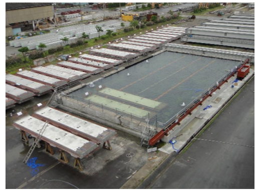
写真-2 水中養生状況
