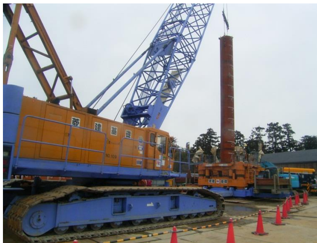
写真-1 施工状況
