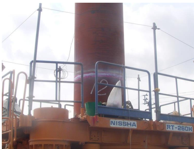
写真-2 鋼管貫入状況
