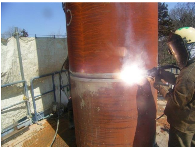
写真-4 現場鋼管溶接状況
