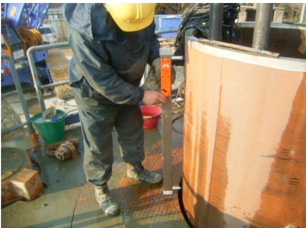
写真-3 ピーコックによる鉛直精度確認状況
