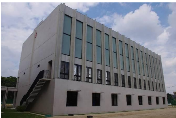
写真-1 建物外観
