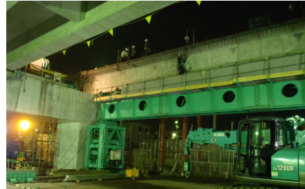
写真-1 桁横取りリフターの施工状況
