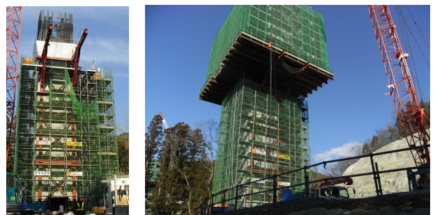
写真-2 支柱式柱頭部ブラケットの施工状況
