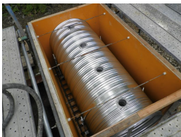
写真-3 点検孔(上面)
