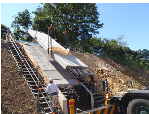
写真-2 斜材架設状況
