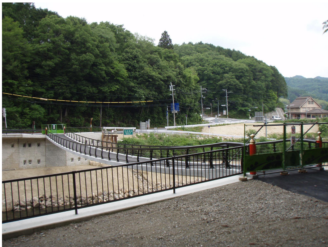
写真-1 完成写真
