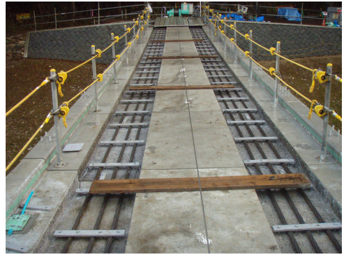
写真-3 プレキャスト版固定状況
