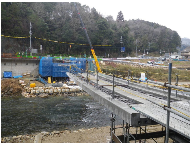
写真-2 架設状況
