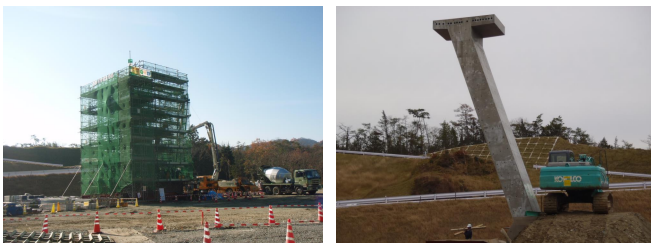
打設状況 (全景)
