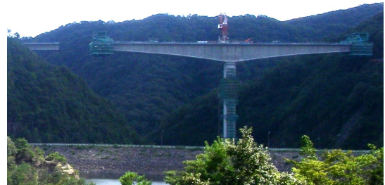
写真-3 張出し架設施工状況
