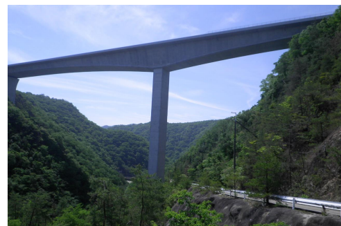
写真-4 完成全景
