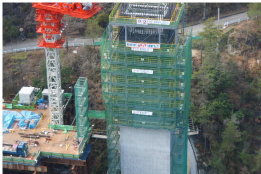
写真-1 P2 橋脚施工状況
