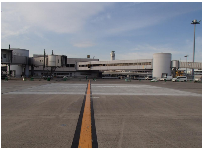
写真-1 工事完了
