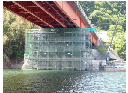
写真-2 あごうじ橋施工状況
