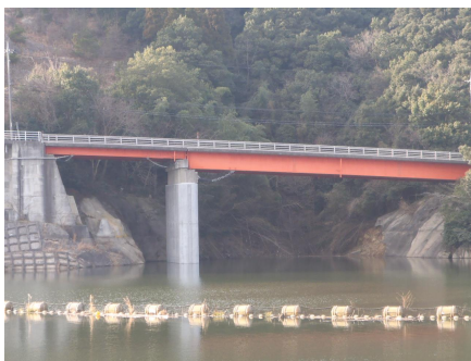
写真-1 白山橋完成
