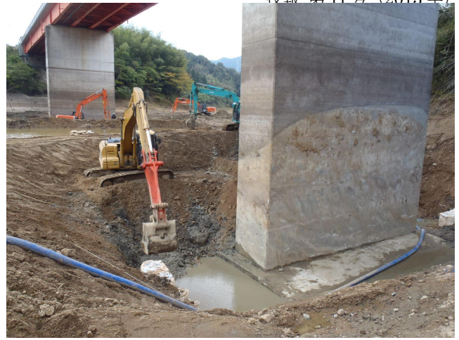
写真-4 掘削状況
