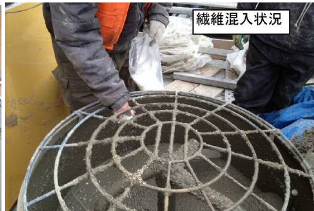
写真-6 繊維混入状況
