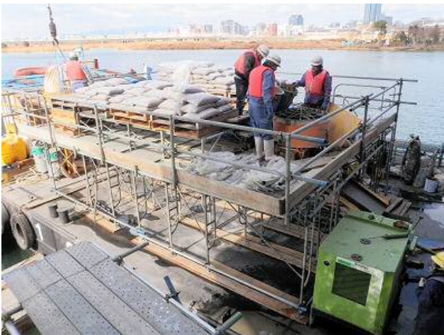
写真-3 水中不分離モルタル練混ぜ状況
