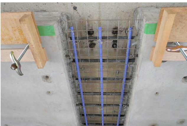
写真-5 2次コンクリート部補強状況
