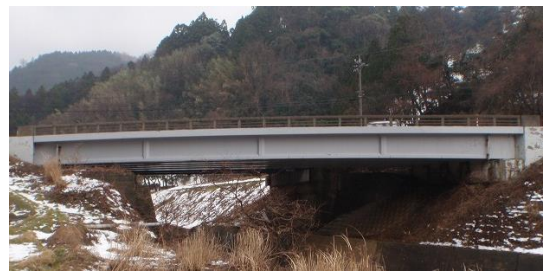
写真-1 施工橋梁
