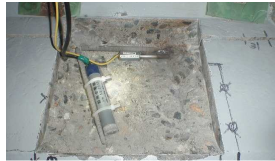
写真-3 照合電極の設置状況
