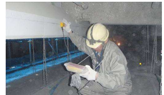
写真-5 鋼材かぶりの確認状況
