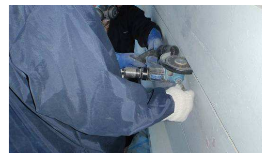
写真-6 溝切削状況
