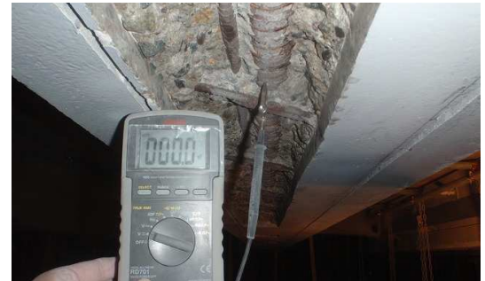
写真-4 鋼材の導通確認状況
