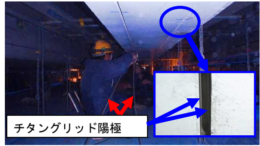
写真-8 桁底面の陽極設置状況
