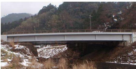
写真-1 施工橋梁
