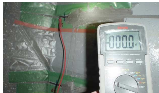
写真-11 陽極間導通確認状況
