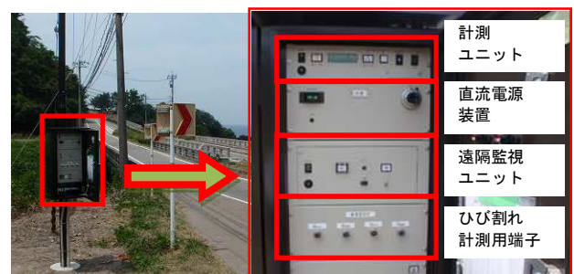
写真-12 直流電源装置設置状況
