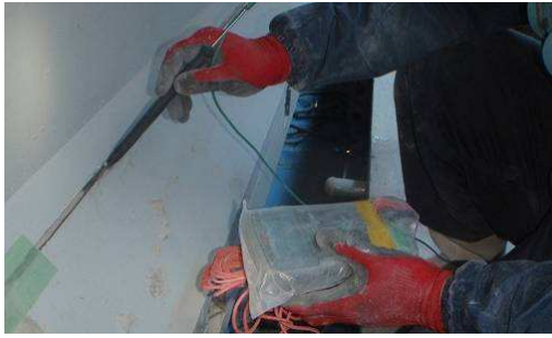
写真-7 露出金属探査状況
