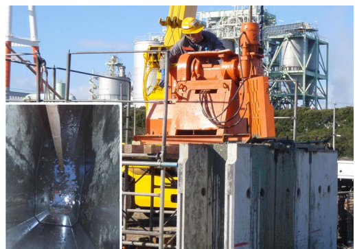
写真-1 高圧攪拌工法による間詰め部の構築状況
