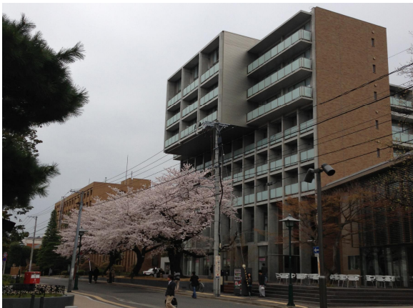
写真-1 建物外観
