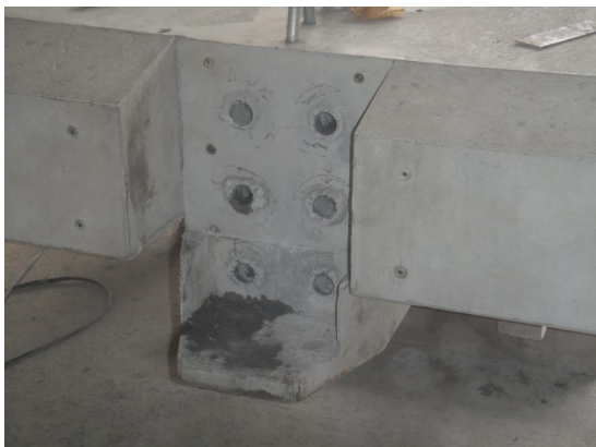
写真-2 片持ち PCa 梁の先端形状
