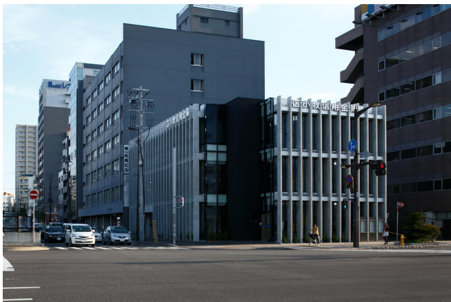
写真-1 建物外観
