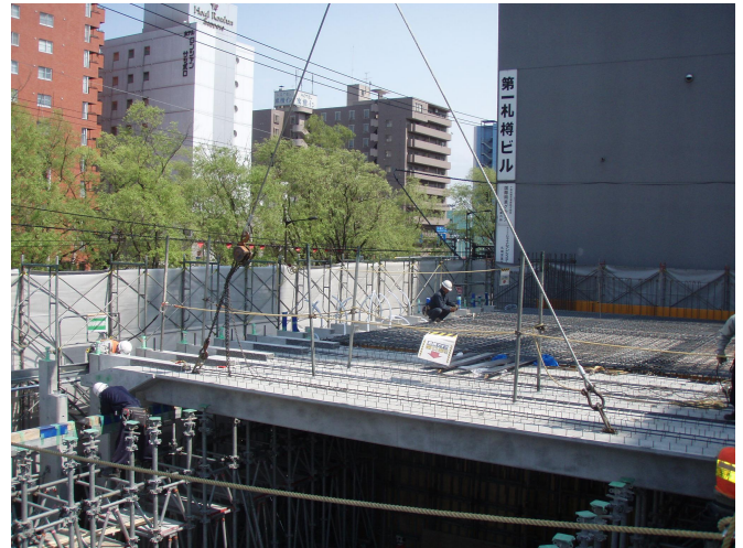
写真-5 PC床版架設作業状況
