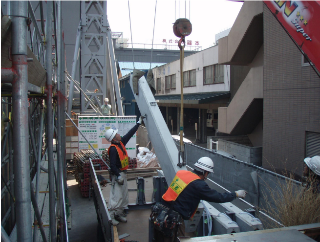
写真-3 柱建て起こし作業状況
