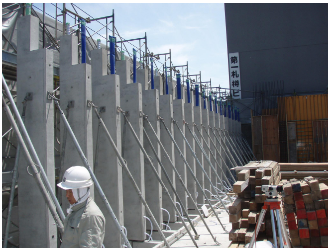
写真-4 柱架設完了状況
