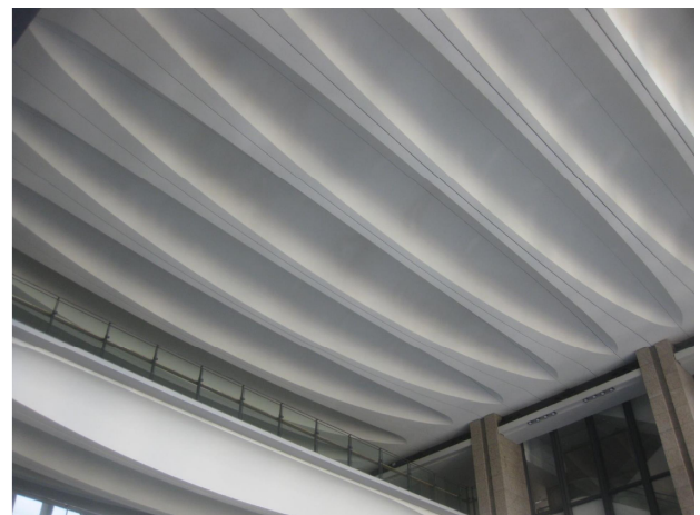
写真-3 架設完了状況
