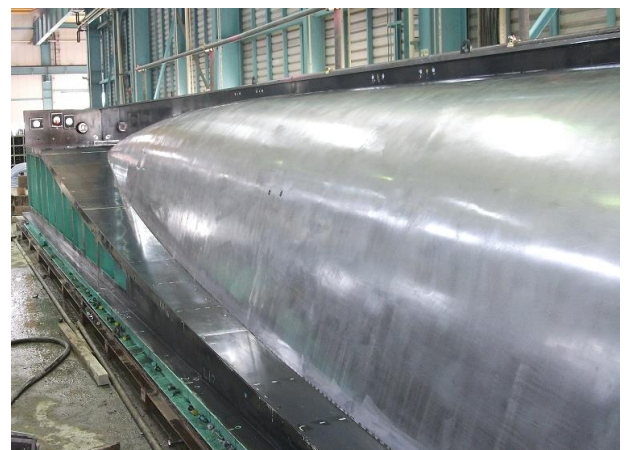
写真-1 鋼製型枠設置状況
