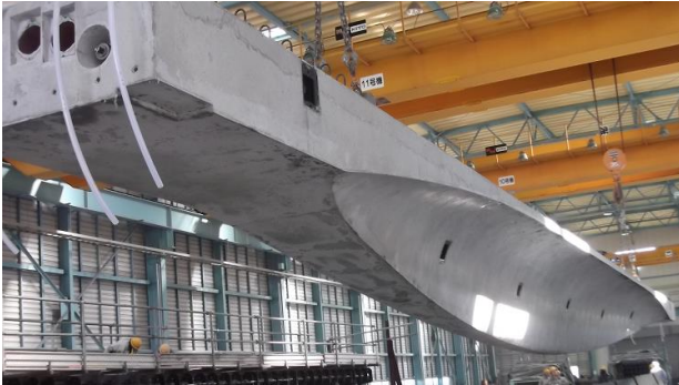
写真-2 部材製作状況 (脱型時)
