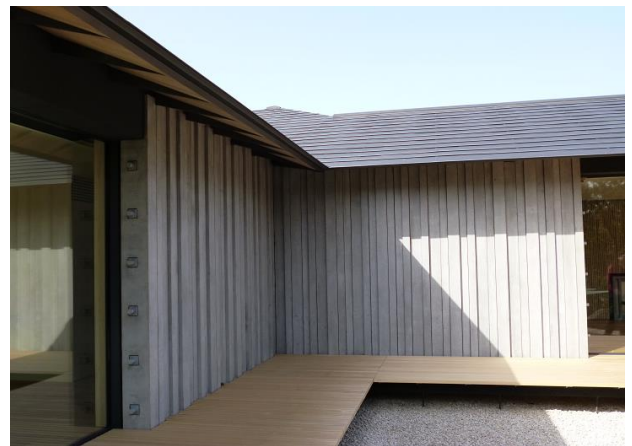
写真-2 施工完了状況
