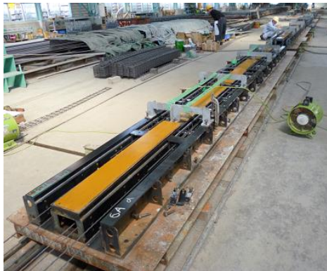
写真-1 PCa 部材製作状況
