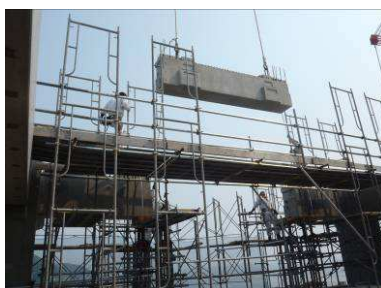
写真-4.2.9 あと施工ブロック梁架設
