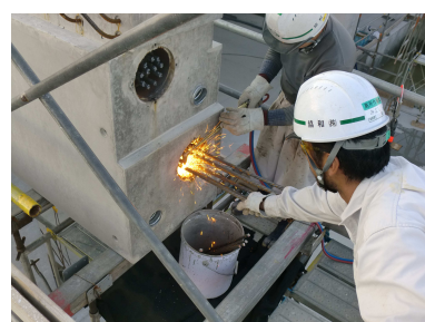
写真-4.2.8 緊張端部処理
