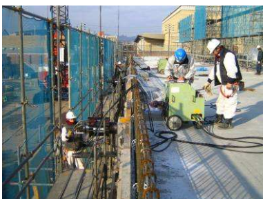
写真-4.2.7 梁 PC 鋼より線緊張
