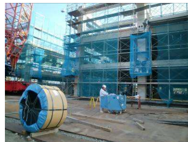
写真-4.2.10 PC 鋼より線通線
