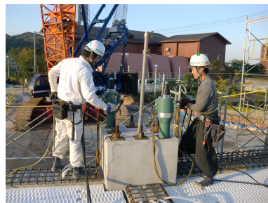
写真-4.2.6 柱 PC 鋼棒緊張
