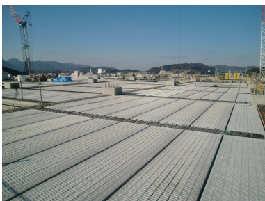
写真-4.2.5 床版架設
