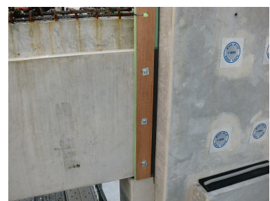
写真-4.5.3 目地型枠
