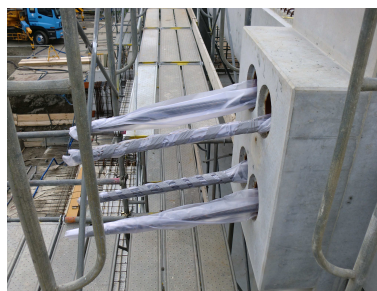
写真-4.5.2 PC 鋼より線養生状況
