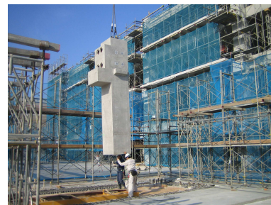
写真-4.2.2 柱架設
