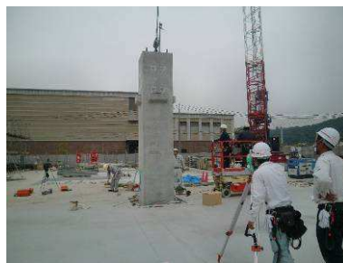
写真-4.4.1 柱建方管理状況
