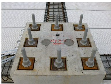
写真-4.5.1 PC 鋼棒養生状況
