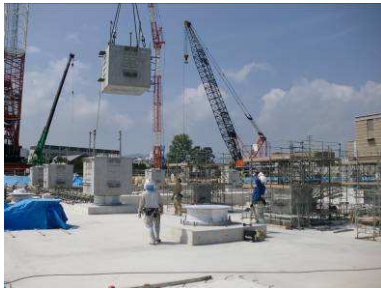
写真-4.2.1 免震ブロック架設
