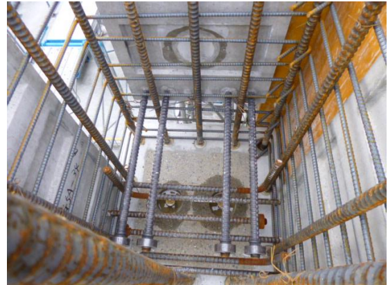
写真-2 パネルゾーン配筋状況
