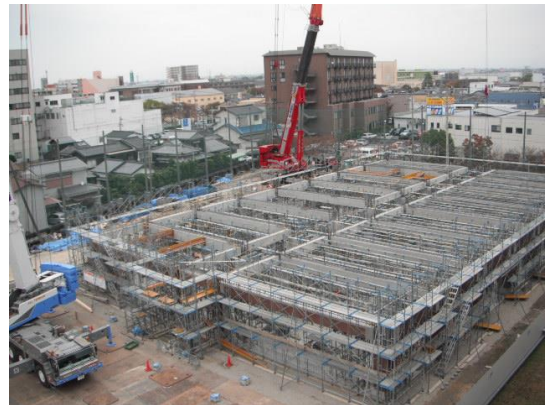
写真-3 PCa 部材組み立て状況
