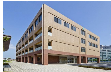
写真-1 建物外観
