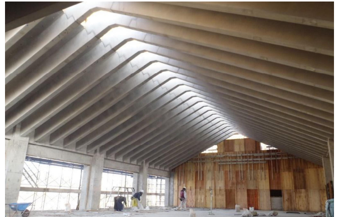
写真-4 支保工解体後
