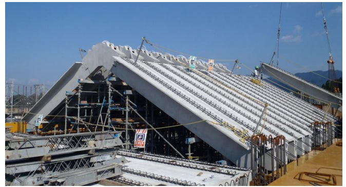
写真-3 山形 PCa 床版架設状況
