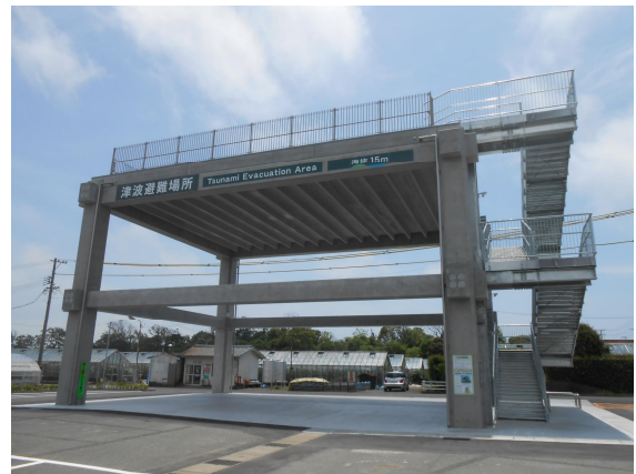
写真-1 菊浜地区津波避難施設
