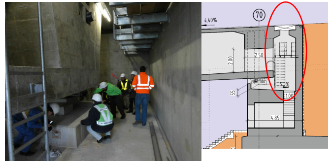
写真-2 桁端部遊間の点検スペース
