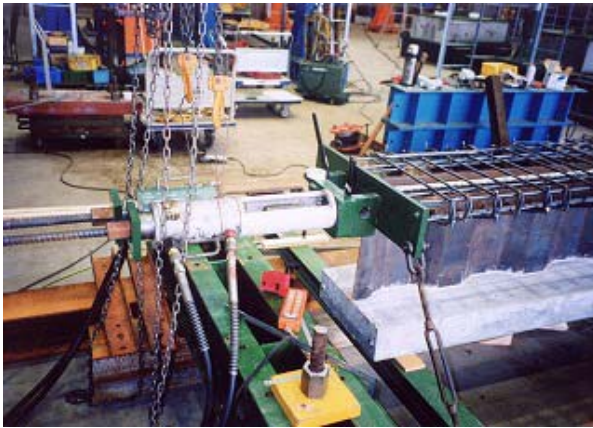
写真-1 緊張力導入状況
