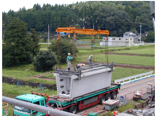
写真-3 セグメント吊上げ状況
