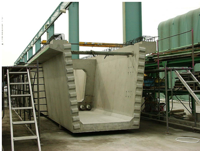
写真-2 主桁セグメント
