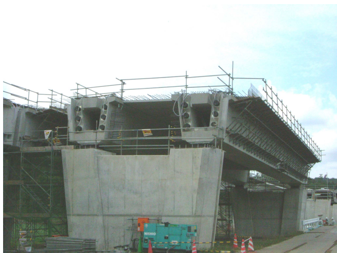
写真-1 U コンポ橋断面形状
