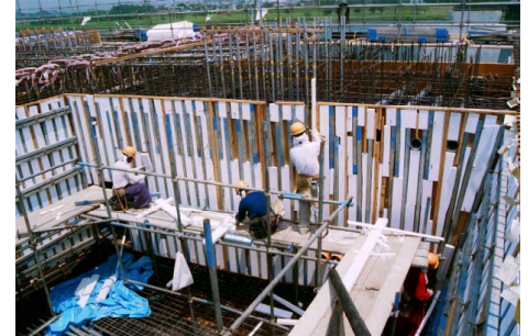
写真-1 型枠設置状況
