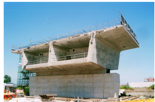
写真-3 柱頭部完成写真
