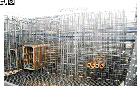
写真-2 クーリングパイプ設置状況
