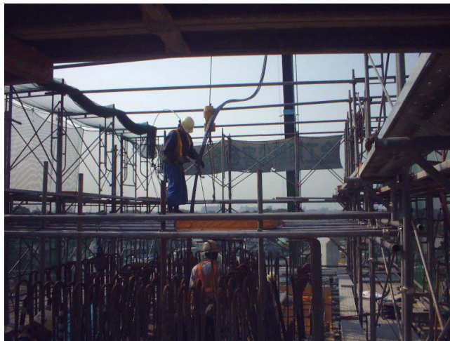
写真-6 PC鋼材挿入状況
