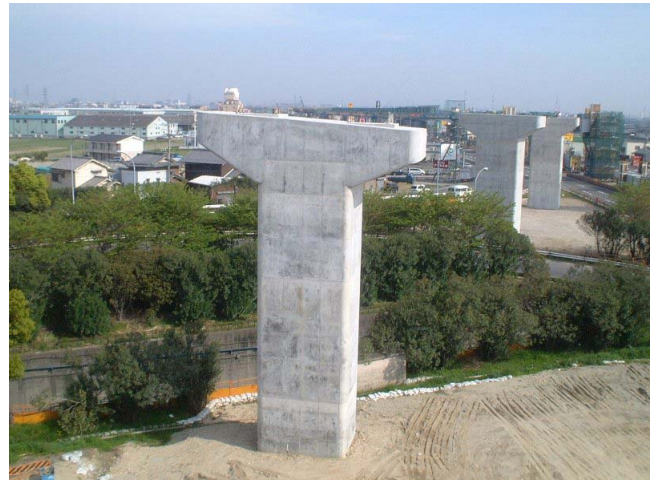
写真-8 施工完了状況
