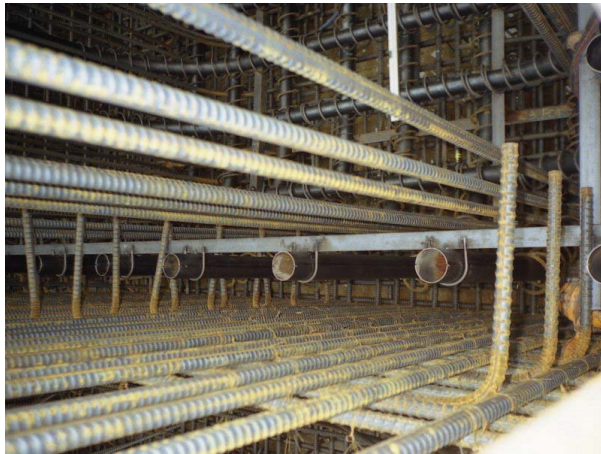
写真-4 シース固定状況
