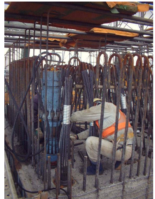
写真-7 PC鋼材緊張状況
