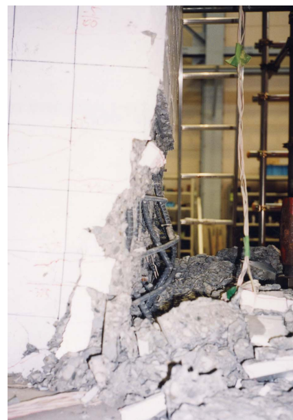
写真-2 供試体破壊状況(2)
