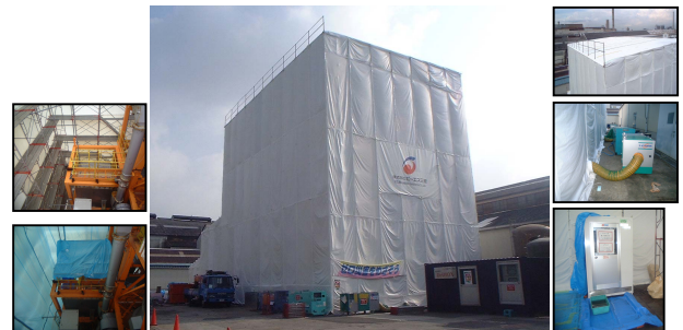
写真-5 仮設隔離養生
