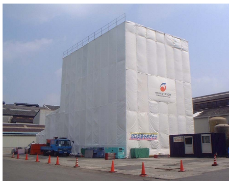
写真-2 隔離養生全景
