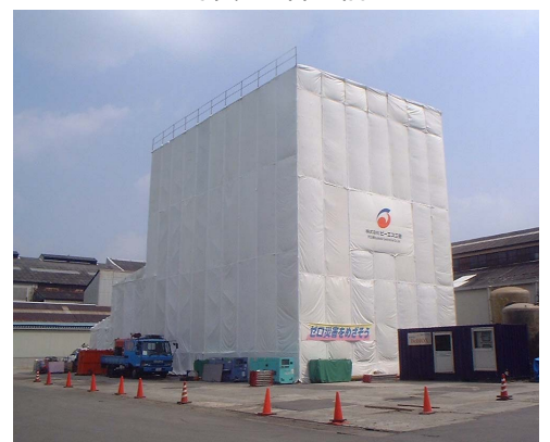
写真-2 隔離養生全景
