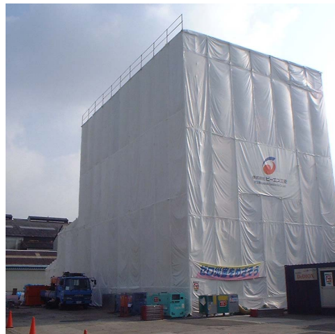
写真-9 仮設隔離養生
