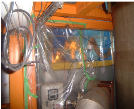
写真-21 隔離養生内作業
