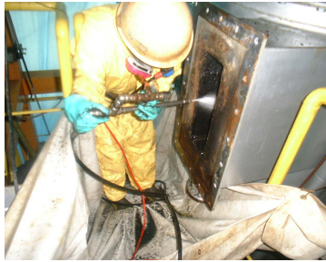
写真-11 ガンノズル洗浄作業
