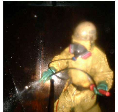
写真-4 付着物除去状況
