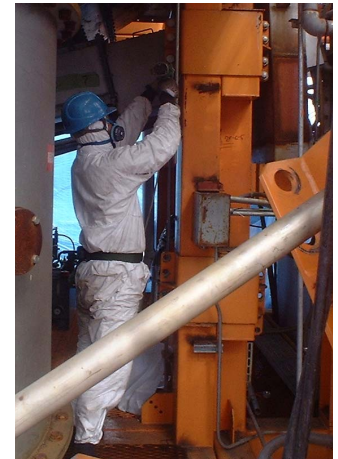
写真-6 解体状況
