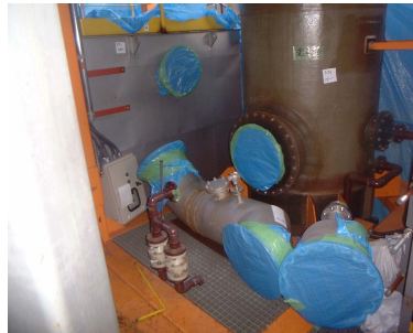
写真-16 開口養生
