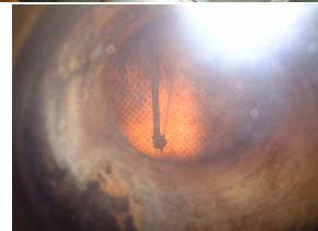
写真-13 3Dノズル洗浄作業
