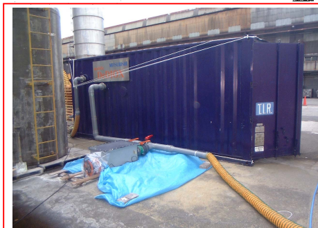
写真-23 DeDIOX 入口測定状況
