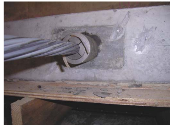
写真-2 緊張試験状況
