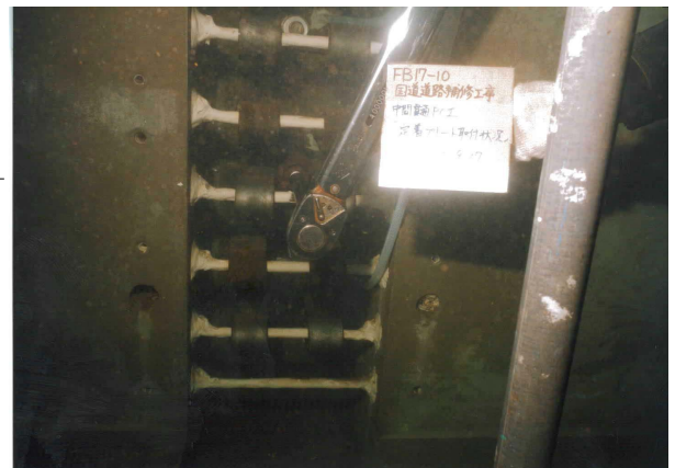
写真-6 トルクレンチによる緊張
