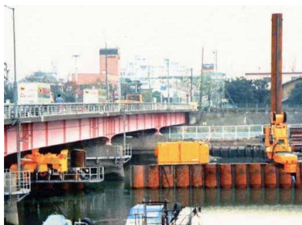
写真-1 限られた桁下空間での仮締切りの例
