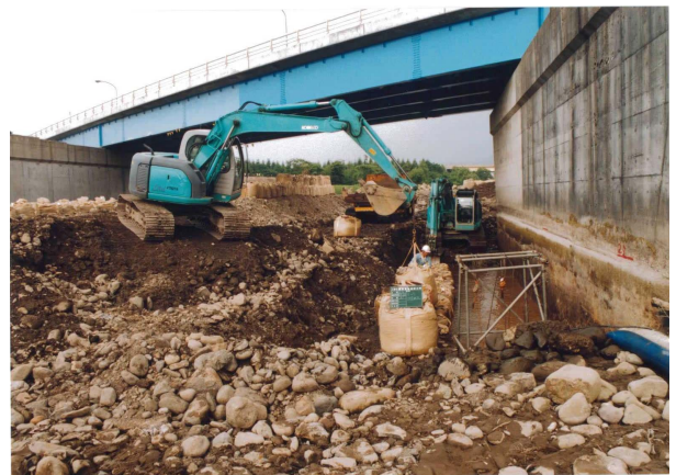
写真-3 河床掘削
