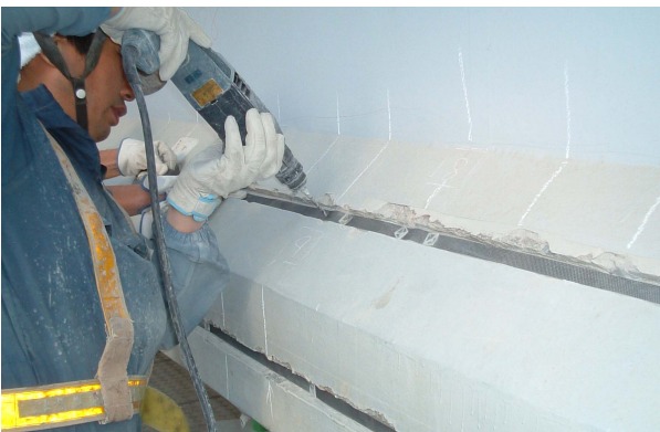
写真-2 陽極の設置
