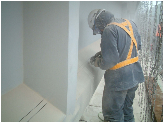
写真-7 カッター状況
