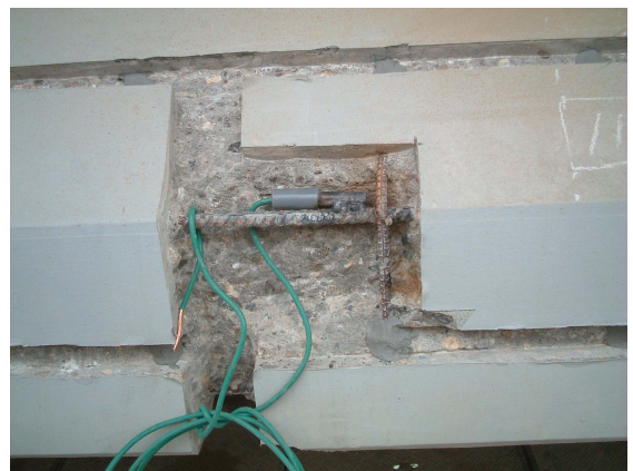
写真-12 排流端子取付け状
