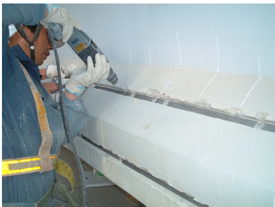
写真-13 陽極設置状況
