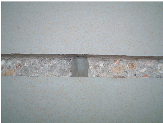
写真-9 絶縁処理状況
