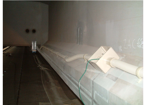
写真-16 桁部配管状況
