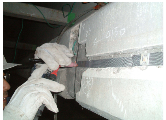
写真-14 スポット溶接状況
