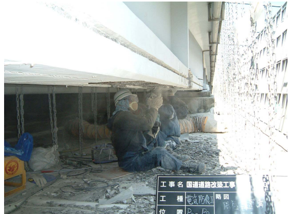
写真-8 はつり状況
