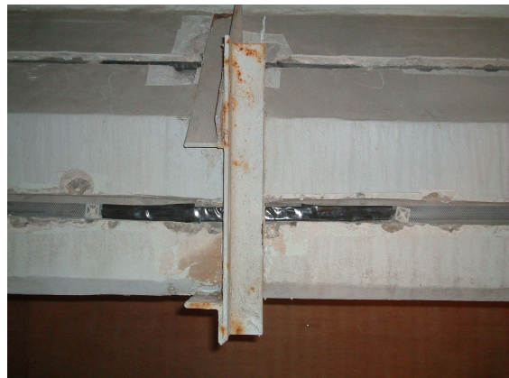
写真-10 チタングリッド陽極絶縁処理状況
