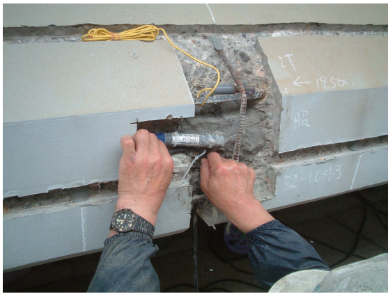
写真-11 照合電極取付け状
