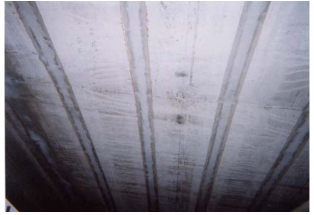
写真-3 陽極埋戻し完了時
