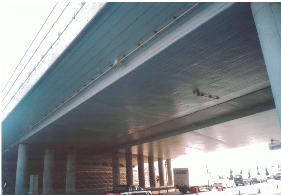
写真-4 完成写真(全景)
