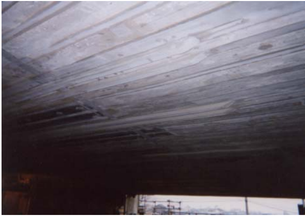
写真-3 陽極埋戻し完了時
