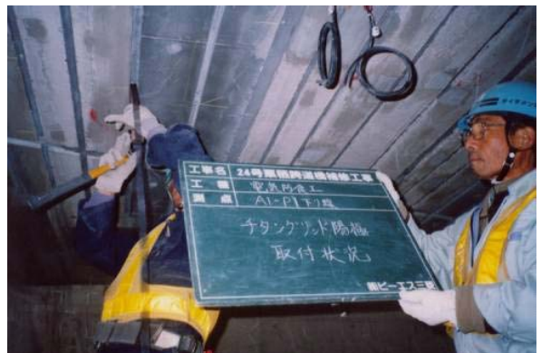
写真-2 陽極設置状況
