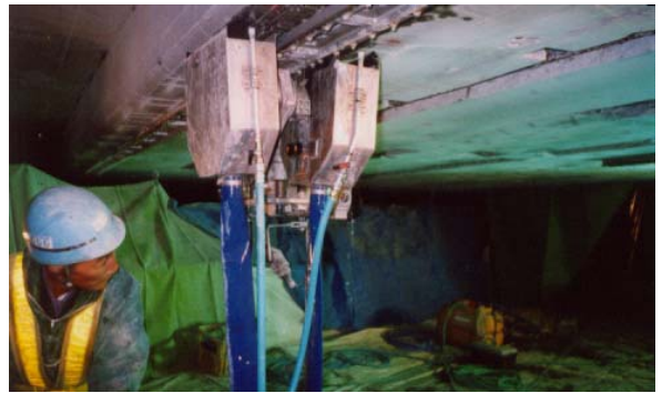
写真-1 陽極設置溝切削状況
