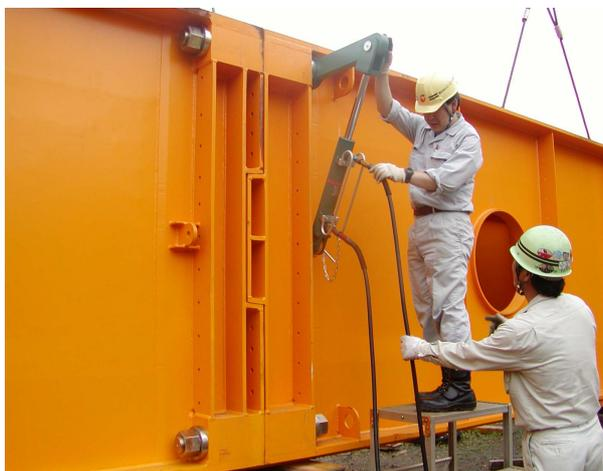
写真-2 テンションロッド締結状況
