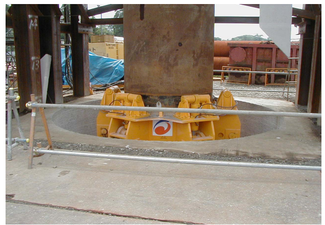
写真-6 掘削終了
