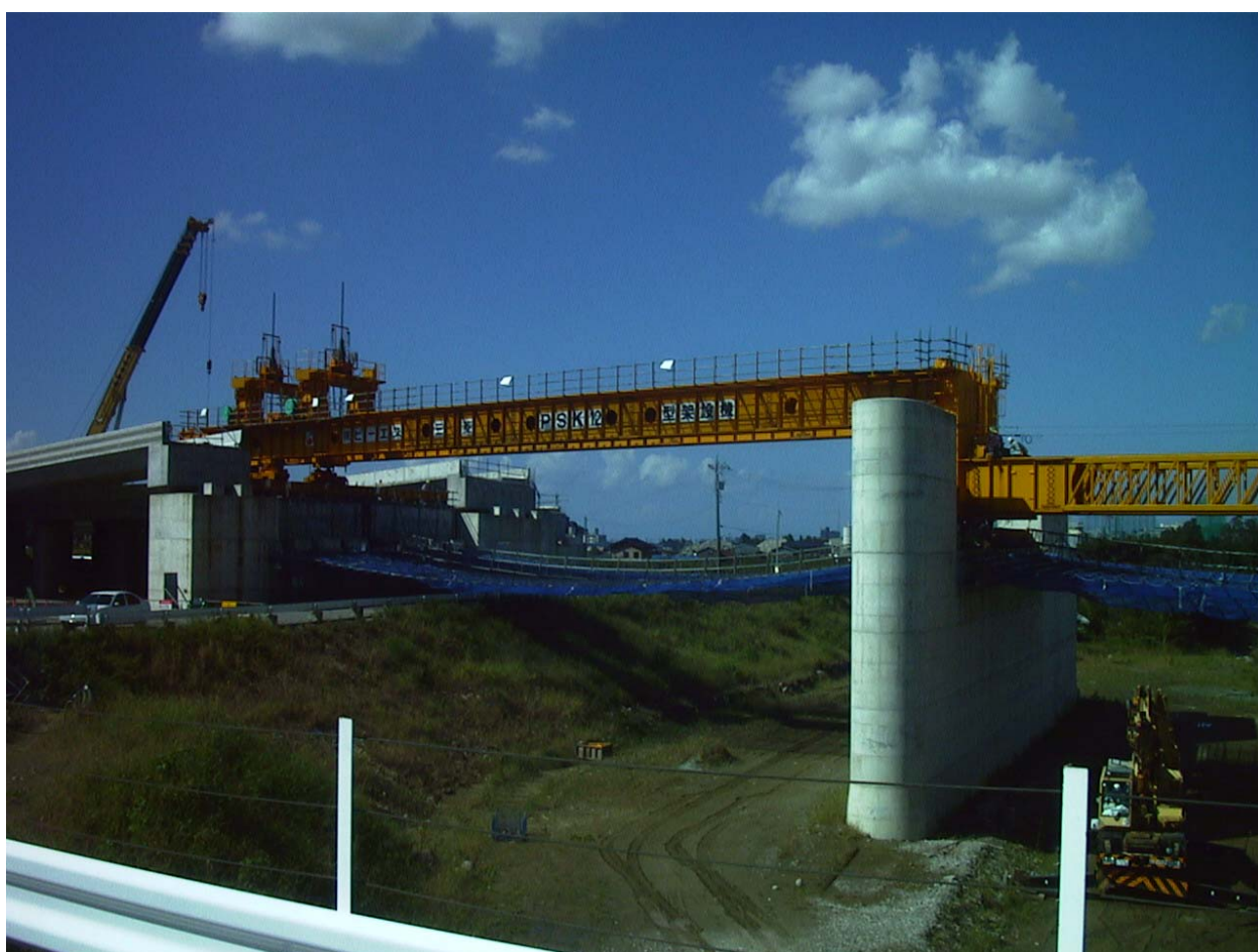
写真-8 PSK12 組立完了状況
