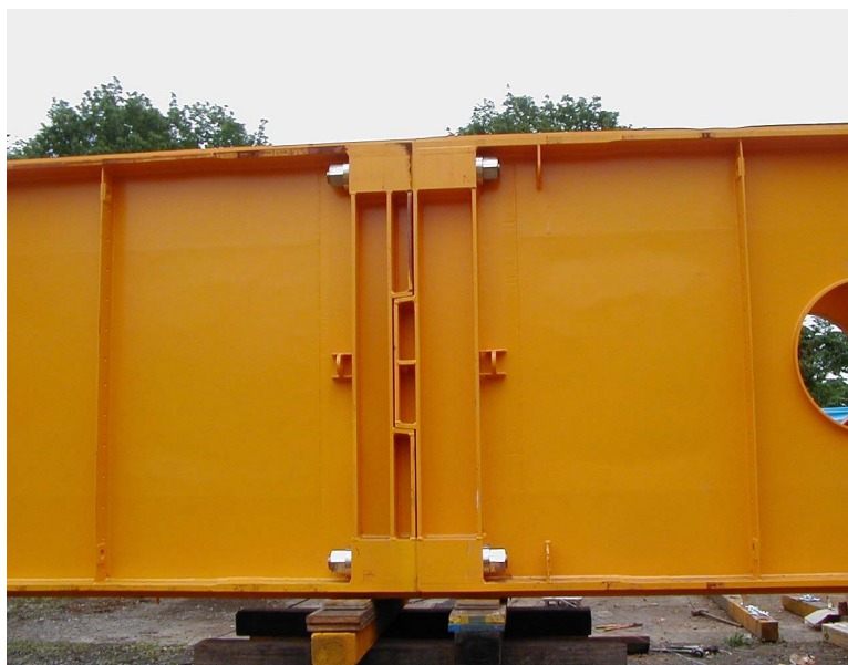
写真-1 TRJ ジョイント締結状況
