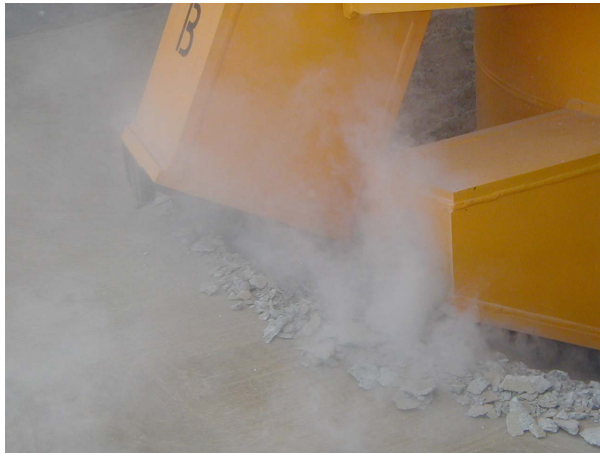
写真-5 掘削状況
