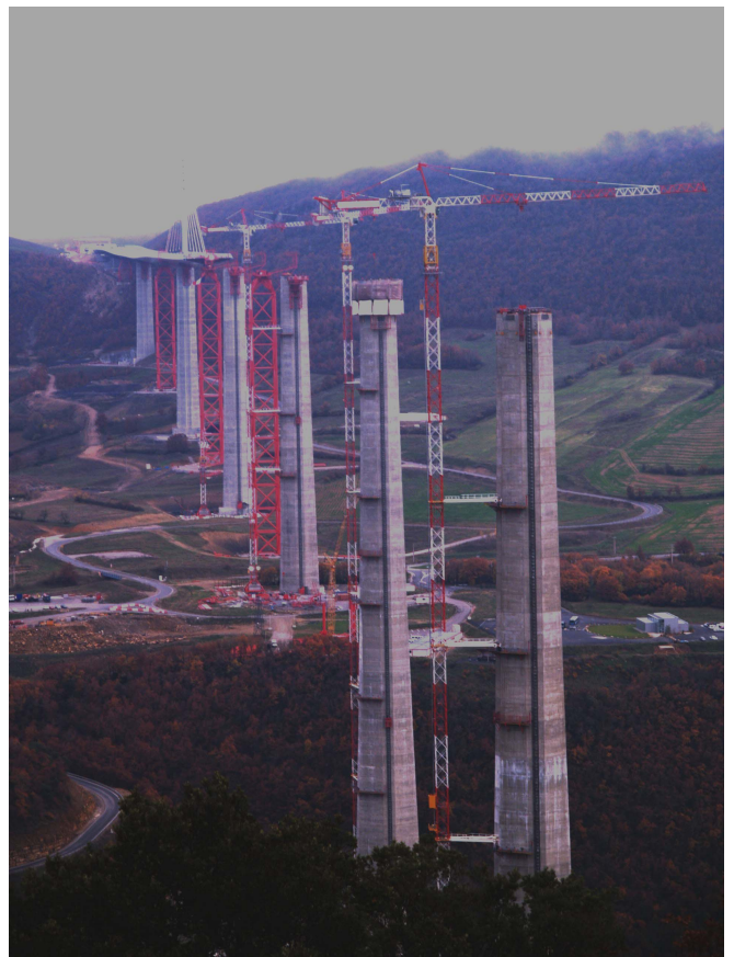
写真-3 南側橋台からの押し出し状況
