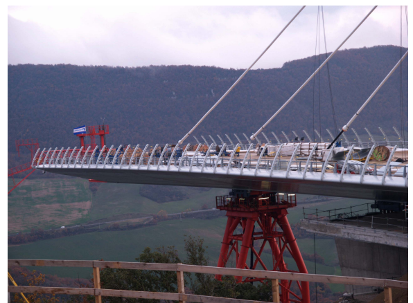
写真-10 北側主桁先端部
