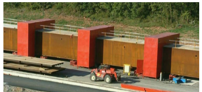
写真-6 主桁組立写真
