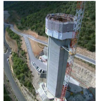
写真-4 P2橋脚施工写真
