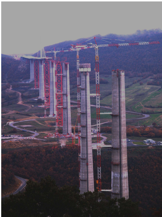
写真-9 南側橋台からの押し出し状況
