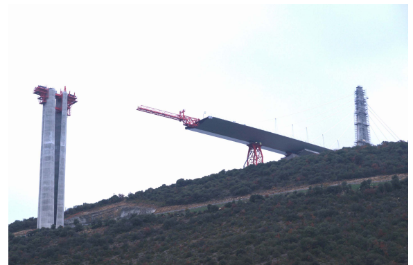
写真-8 北側橋台からの押し出し状況
