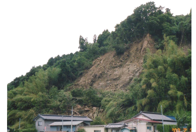
写真-2 矢本町 鹿妻地内の斜面崩壊(土砂は住家裏直前で停止)
